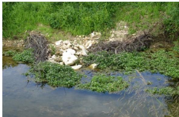
**Abbildung 10 Beispiel für den Einbau von Astbündeln kombiniert mit Wasserbausteinen**
